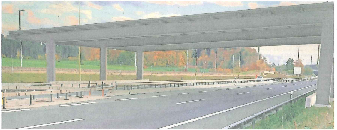
So könnte die Überdachung aussehen; Blick von Affoltern in Richtung Mettmenstetten. (Bildmontage Standortförderung Knonauer Amt mit Modellausschnitt der Servipier AG)
